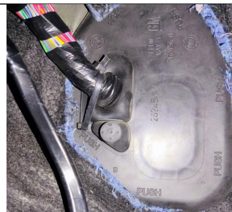
Проход жгута проводов в подкапотное пространство
